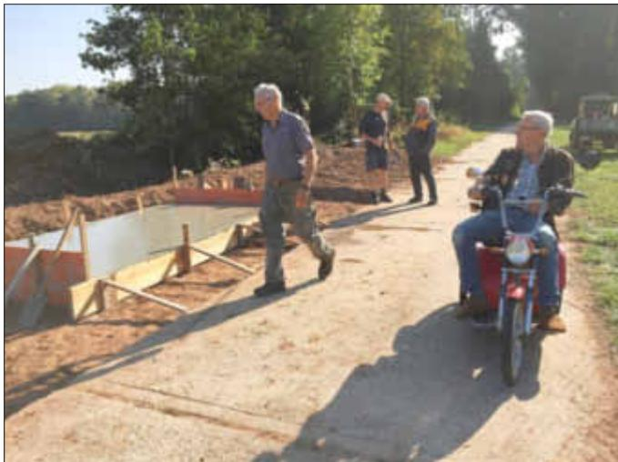
Wie bei jedem Bau, musste zunächst der Boden bearbeitet werden. Christian Kröper fackelte nicht lange und bearbeitete die Fläche mit dem Bagger. Dann war Man-Power gefragt: Hubert Job, Ludwig und Martin Lutz, Hans und Peter Kreiner schalteten die Bodenplatte ein und betonierten diese. Danach wurde das Holz in der Gemeindehalle
