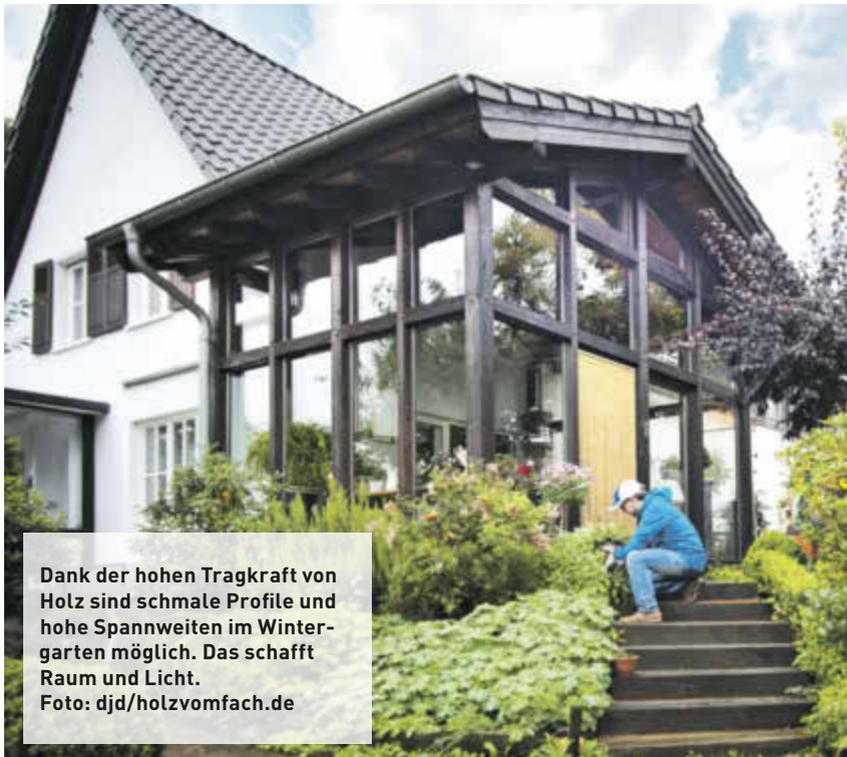
Dank der hohen Tragkraft von Holz sind schmale Profile und hohe Spannweiten im Wintergarten möglich. Das schafft Raum und Licht.
