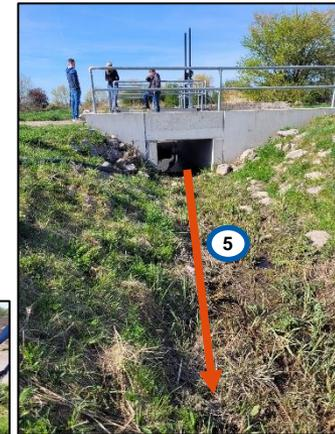
→ Hauptabfluß nach Überschreitung Staubalken „2“ Richtung „5“, da aufgrund tiefer Schützstellung „3“ schnell Einstau
