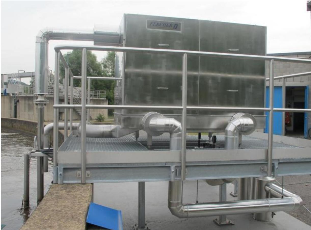
Abbildung 64: Abwasserwärmetauscher FERCHER FB-6/S-1-1 in einem Klärwerk (FERCHER GmbH, 2025)
