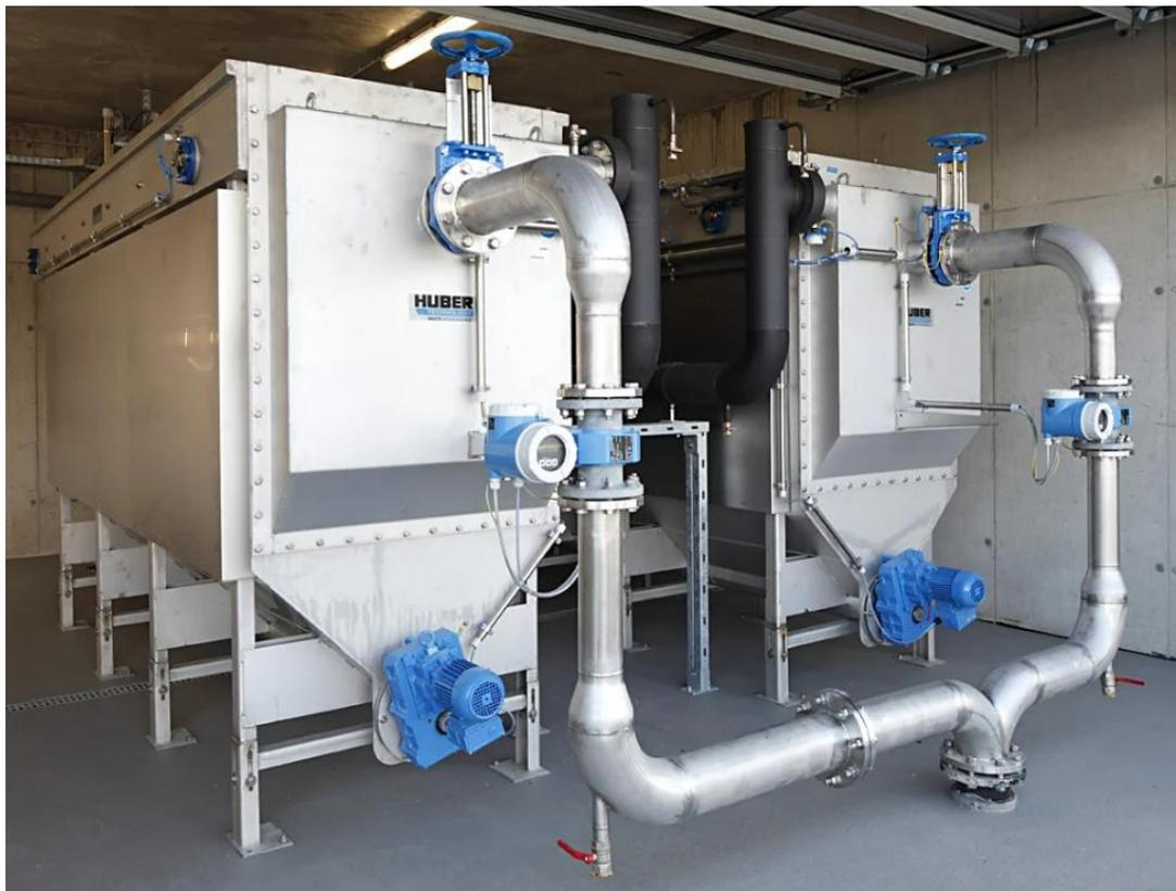
Abbildung 62: Abwasserwärmetauscher RoWin (HUBER SE, 2025)
