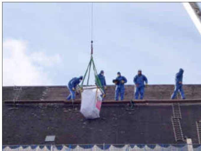
Die Dachdecker bei der Arbeit
