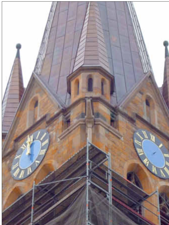
Gerüst wird abgebaut, während ein Uhrzeigerpaar wieder montiert wurde.
