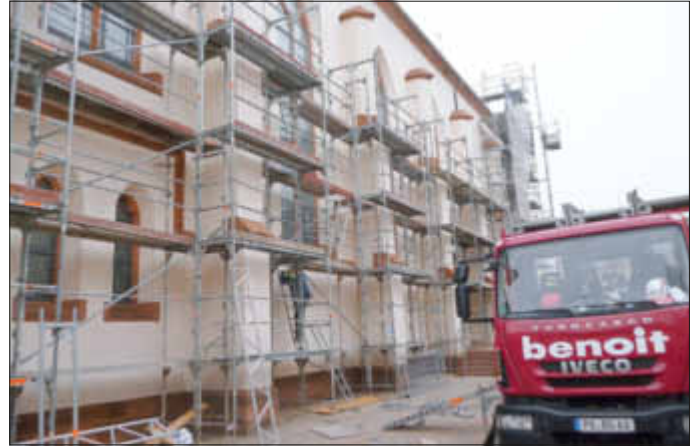
Etage um Etage wird das Gerüst an den Seitenwänden abgebaut
