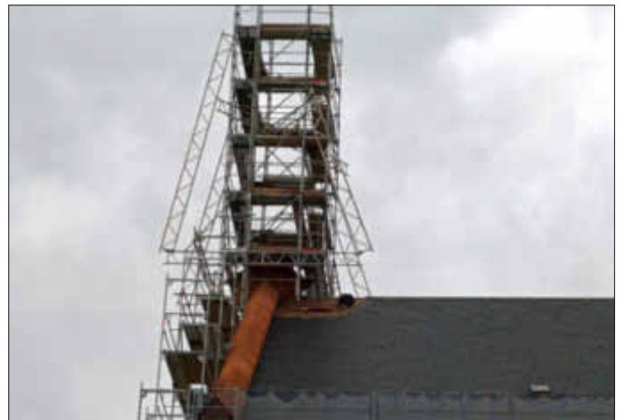
Das Gerüst am zwischenzeitlich demontierten Dachreiter
