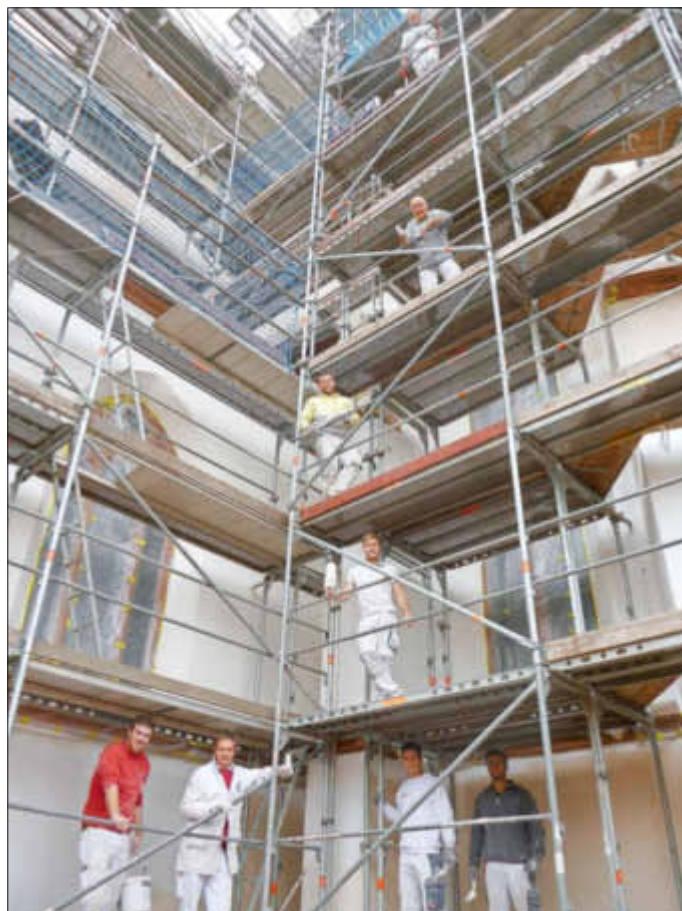
Die Maler sind auf allen Gerüstebenen zu Gange.
