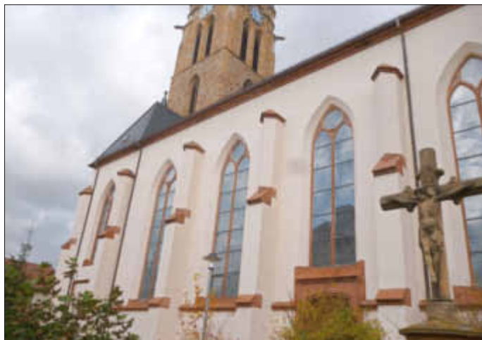
Die neu gestrichene Längsseite der Kirche ist wieder voll einsehbar.
