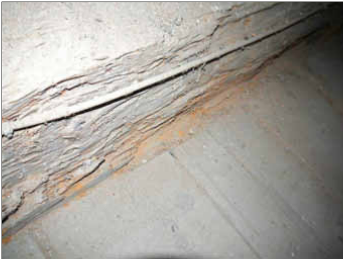
Beschädigte Balken ...
