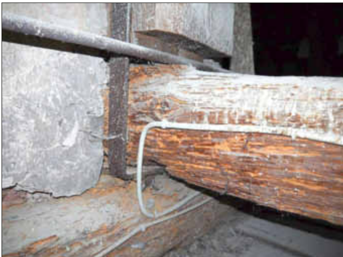
Beschädigte Balken ...
