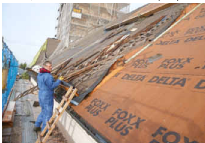
Das alte Kirchendach wird entfernt
