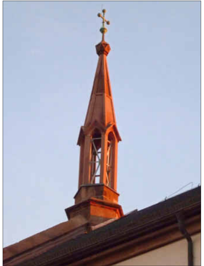
Der Dachreiter nach seiner Sanierung
