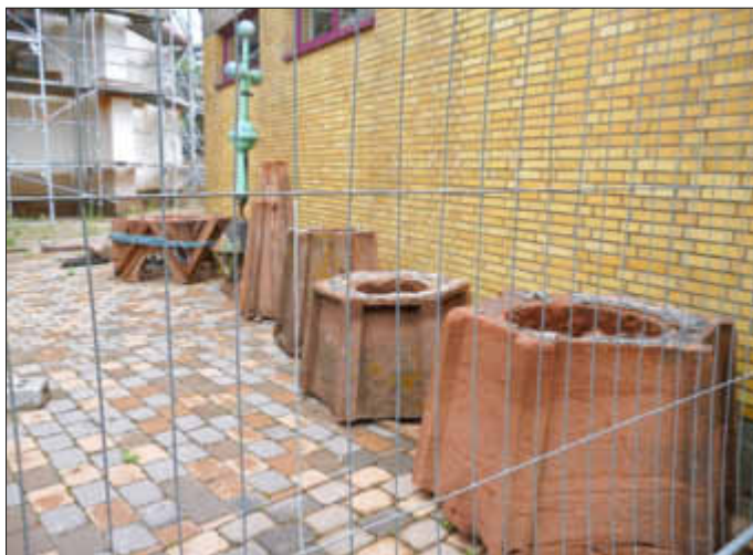
Die Einzelteile des Dachreiters
