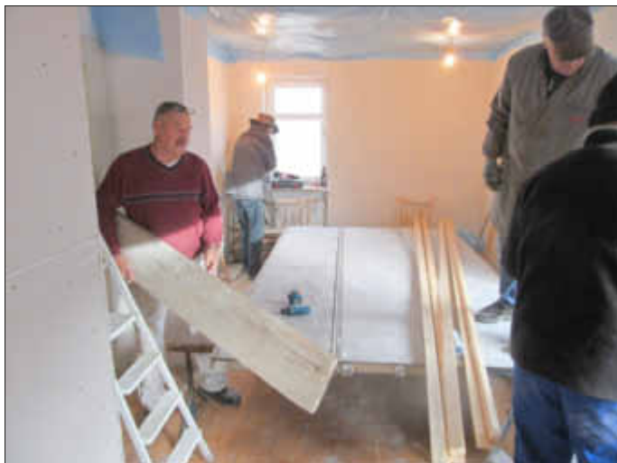
Viele fleißige Helfer bei der Deckenisolierung und -verschalung
