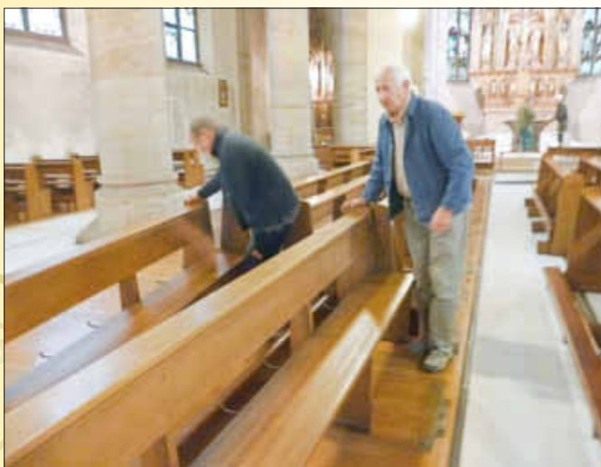
Die Bänke werden demontiert und zusammengestellt
