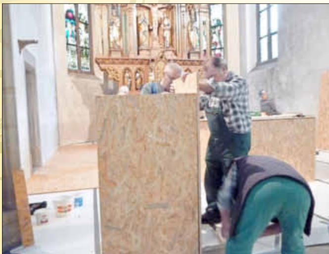
Altäre und Ambo werden mit Holz verkleidet
