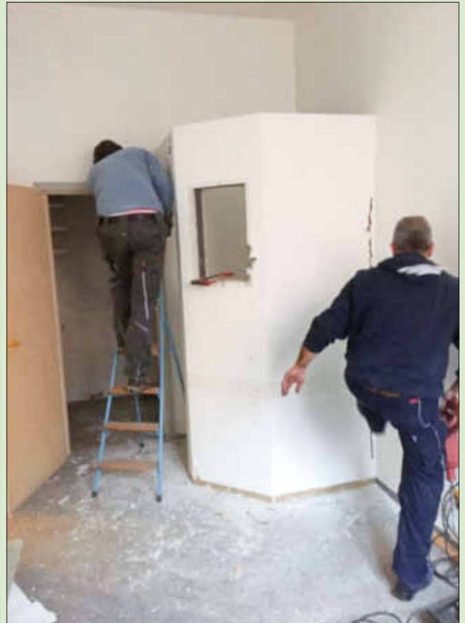
Die Wand wird herausgerissen
