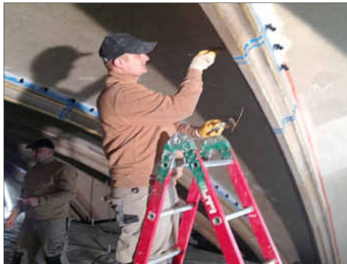
Die Facharbeiter der Fa. Bbr-Bausanierungen GmbH gehen zu Werke
