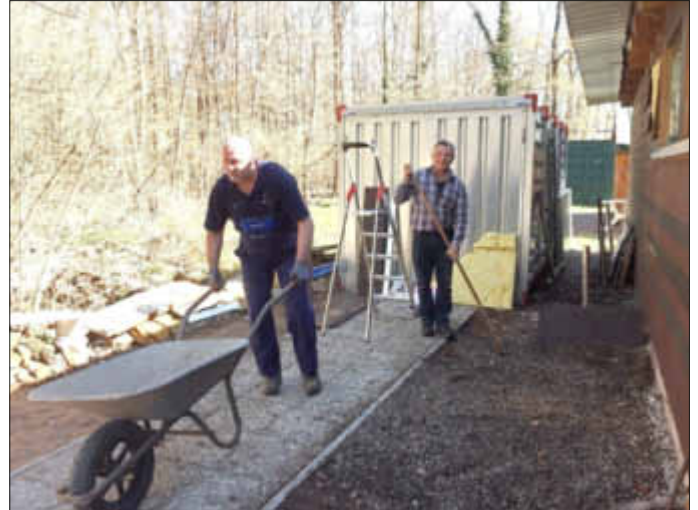
Der neue Weg zum Container erhielt durch Erdaufschüttung einen Rasenstreifen. Die Nordseite unseres Klubhauses wurde durch ein Kiesbett geschützt und Reparaturen vorbereitet.
