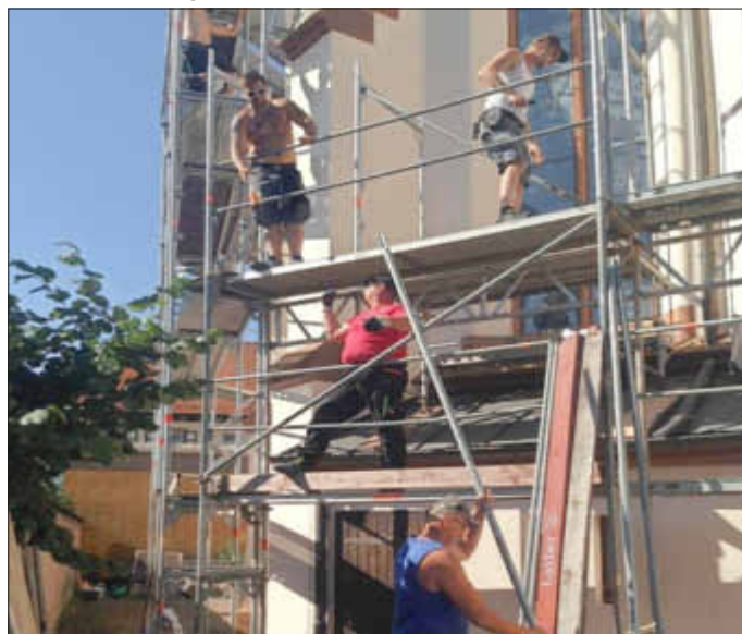
Die Gerüstbauer bei der Arbeit
