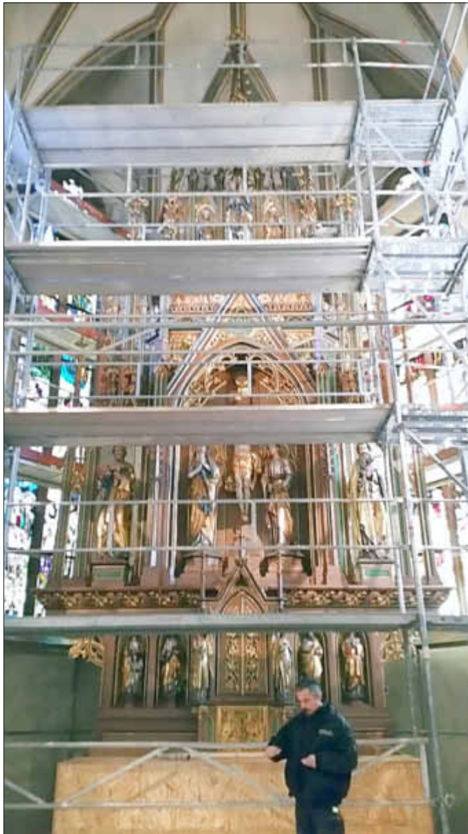
Der noch eingerüstete Hauptaltar
