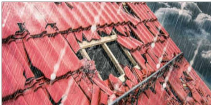
Die immer häufiger auftretenden Unwetter lassen nicht selten Schäden am Dach zurück. In dem Fall können jene Bewohner aufatmen, die sich bei der Errichtung des Hauses für hochwertige Unterdeckbahnen entschieden haben. Diese sind als zweite Funktionsebene unter der ersten, sprich den Dachziegeln, Dachsteinen und Co, befestigt und übernehmen zuverlässig und sicher deren Aufgabe – also zu verhindern, dass beispielsweise Hagel und Regen in die Wärmedämmung beziehungsweise
