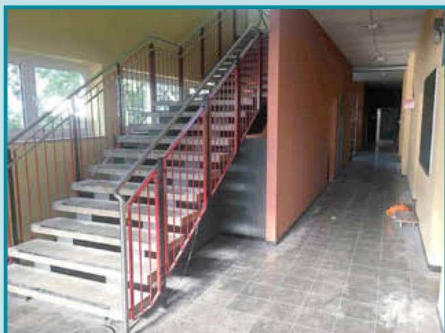
Ein Treppenraum wird geschaffen (Bild 1)
