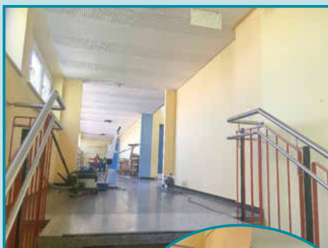
Brandschutztür folgt (Bild 2)
