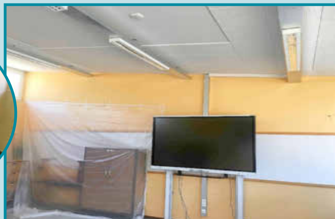
Smartboards und neue Beleuchtung (Bild 5)
