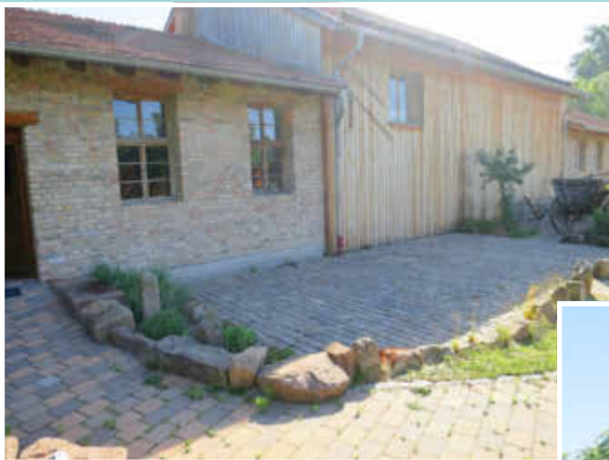
Altes Sägewerk Mittelmühle Bellheim
