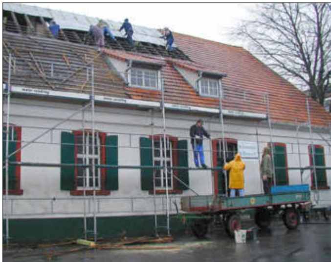
Dachsanierung im Februar 2001
