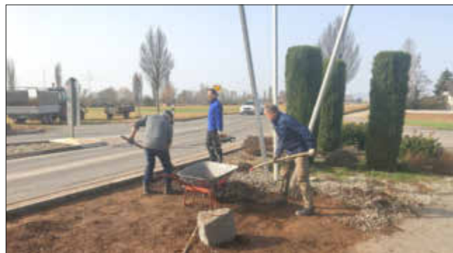
In mühsamer Handarbeit wurden der Kies vom Bauhofteam entfernt.
