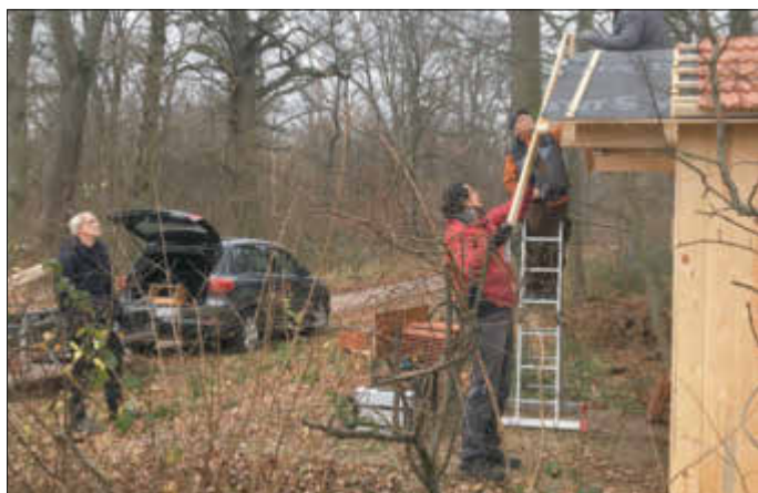
Das Dach wird gedeckt
