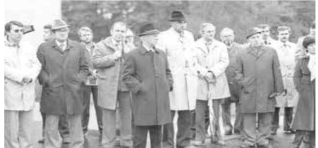
Frühjahr 1981 – Einweihung der neuen Kläranlage Bellheim
