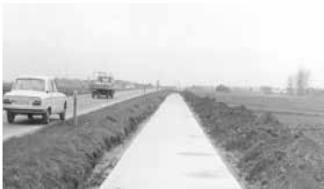
Ausbau erster Radwege - Richtung Knittelsheim
