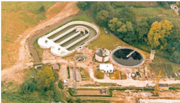
24.09.1981 – technisch verbesserte Kläranlage
