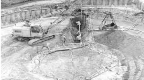
30.03.1979 – Bauarbeiten zur Erweiterung der Kläranlage Bellheim
