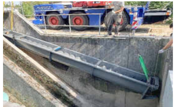
2019 - Sanierung der Hebeanlage Knittelsheim
