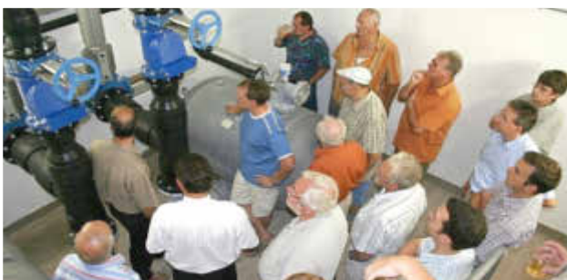
2007 – Einweihung Hebewerk Zeiskam mit Anschluss der Abwässer von Zeiskam an Kläranlage
