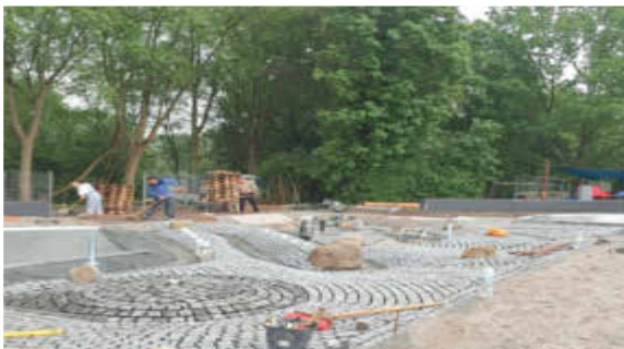
2015 – 2016 – Umbau und Sanierung des Schwimmparks
