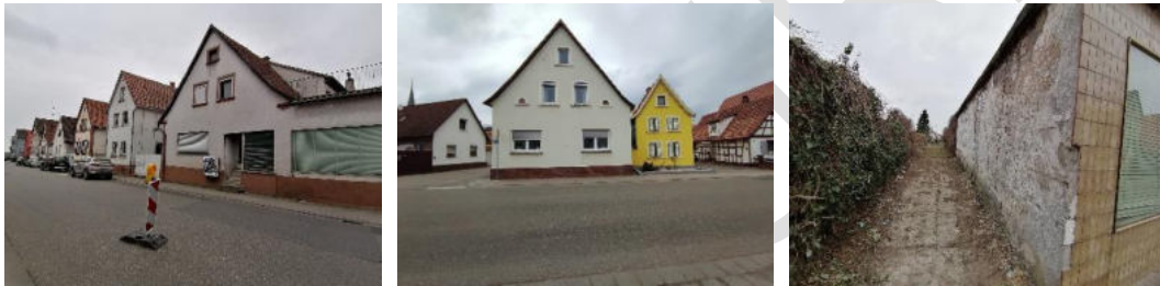
Abbildung 31: Beispiele gestalterische oder bausubstanzielle Mängel; eigene Aufnahme 2023
